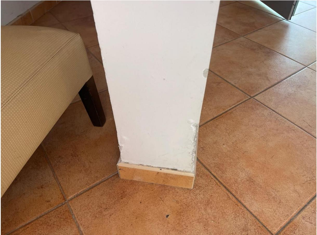
Je remarque une fissure et des traces d'écoulement sur le mur SUD :
