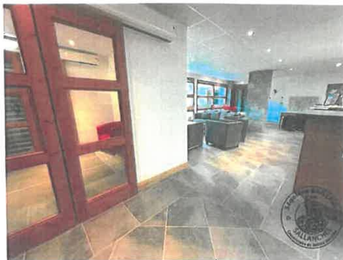
Photographie n°8. Porte automatisée donnant accès au sas
